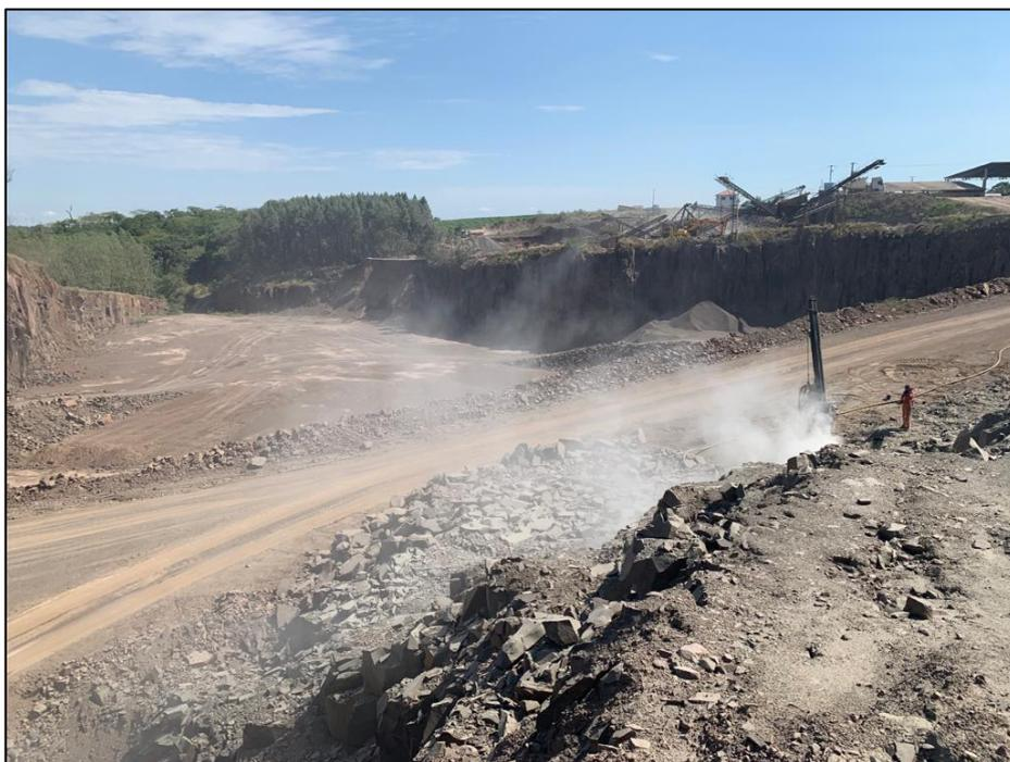
Foto 03 - Área em exploração. Nesta, detalhe para a preparação da frente para novos desmontes.
