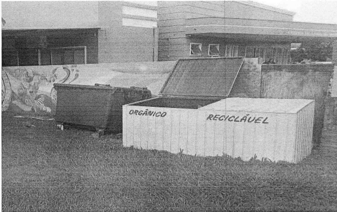
Centro de Saúde de Mercedes (espaço a ser adequado para a instalação do objeto)
