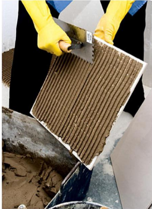
Figura 6 – Aplicação da argamassa no tardo da peça cerâmica
