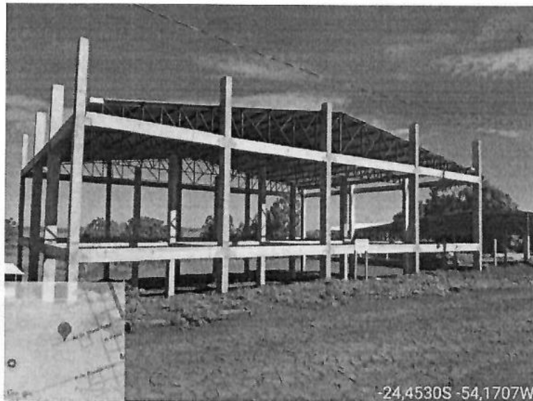
Foto 01: Visão noroeste da edificação do depósito.
