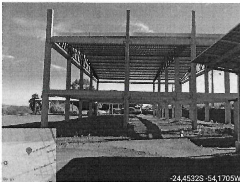
Foto 02: Visão lateral leste da edificação do depósito.
