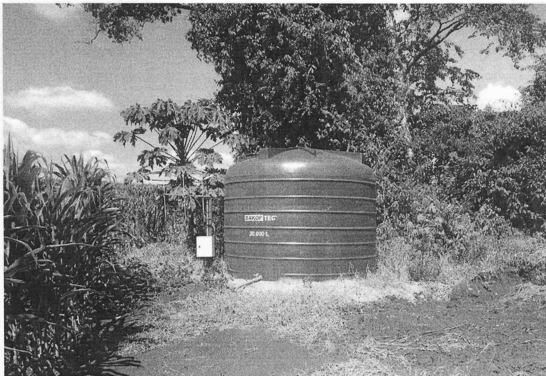
Fig. 14 Reservatório São Marcos 2.
