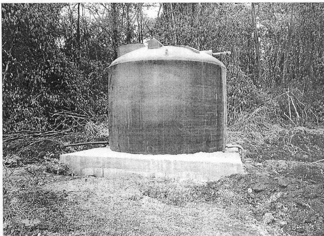
Fig. 08 Reservatório Nova Esperança.
