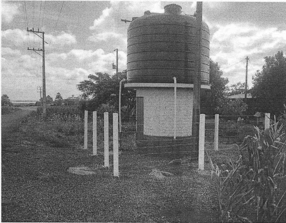
Fig. 10 Reservatório Novo Rio do Sul.
