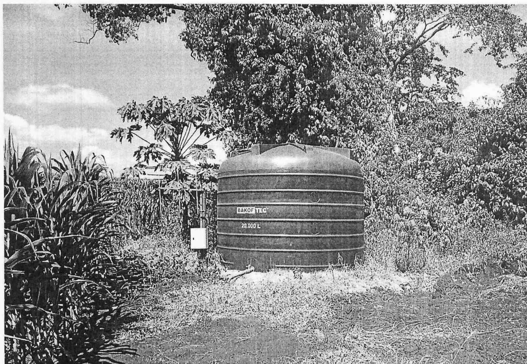
Fig. 14 Reservatório São Marcos 2.
